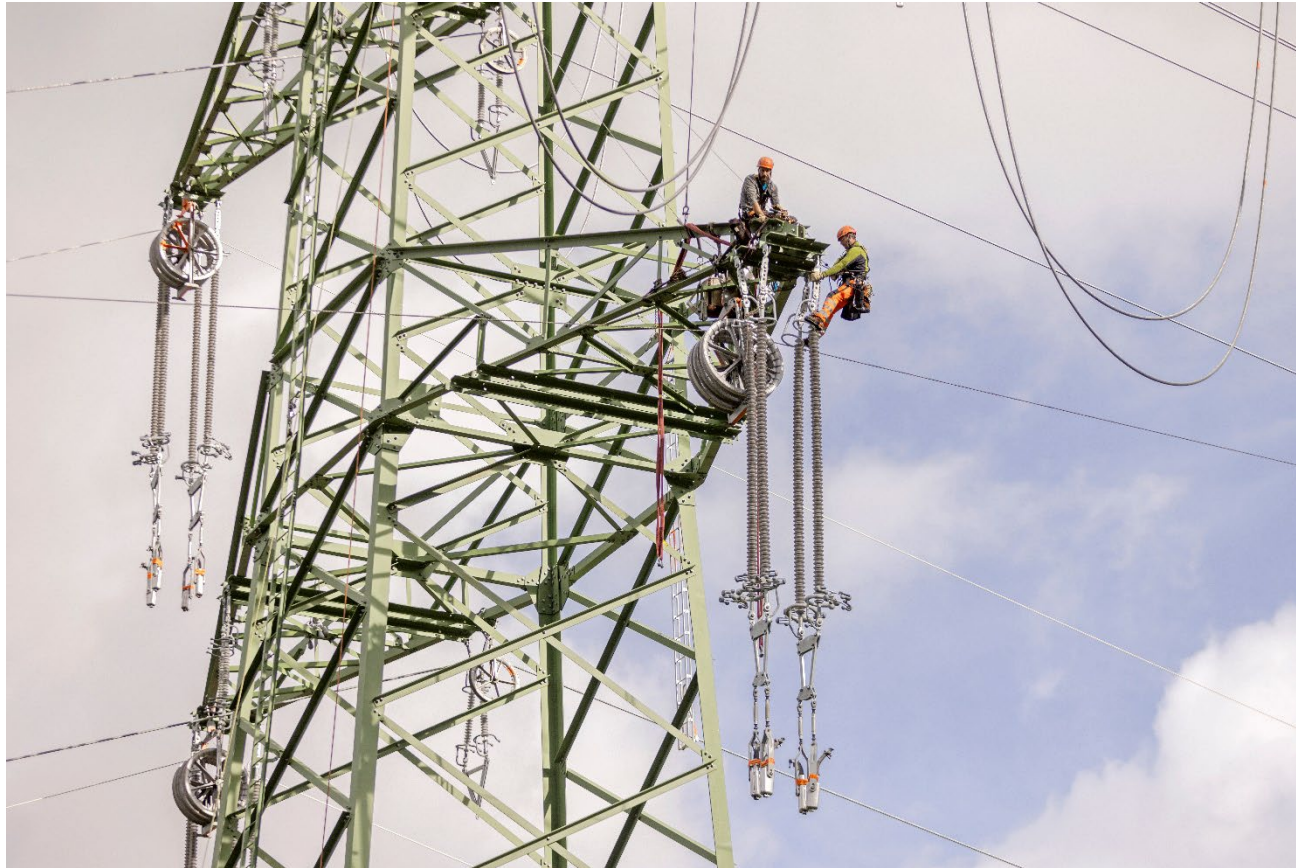
Montage der Isolatorenketten
