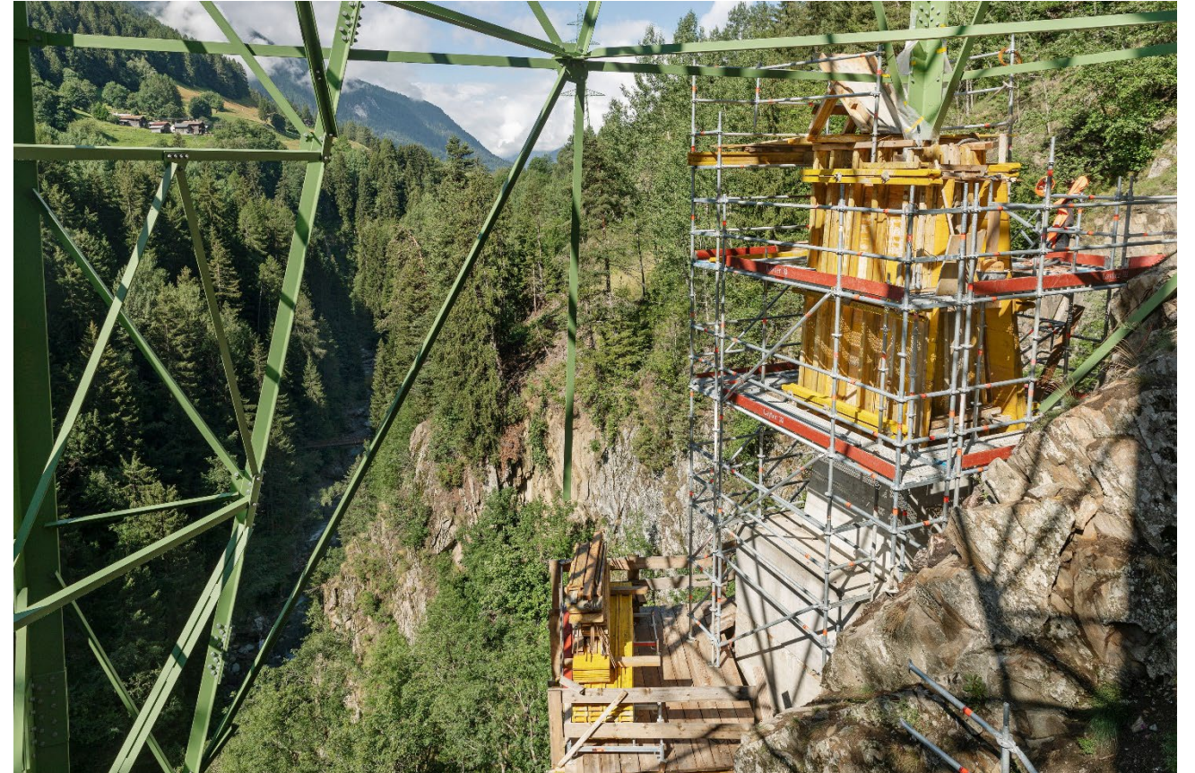
Fundamentkopf betonieren im felsigen Hang
