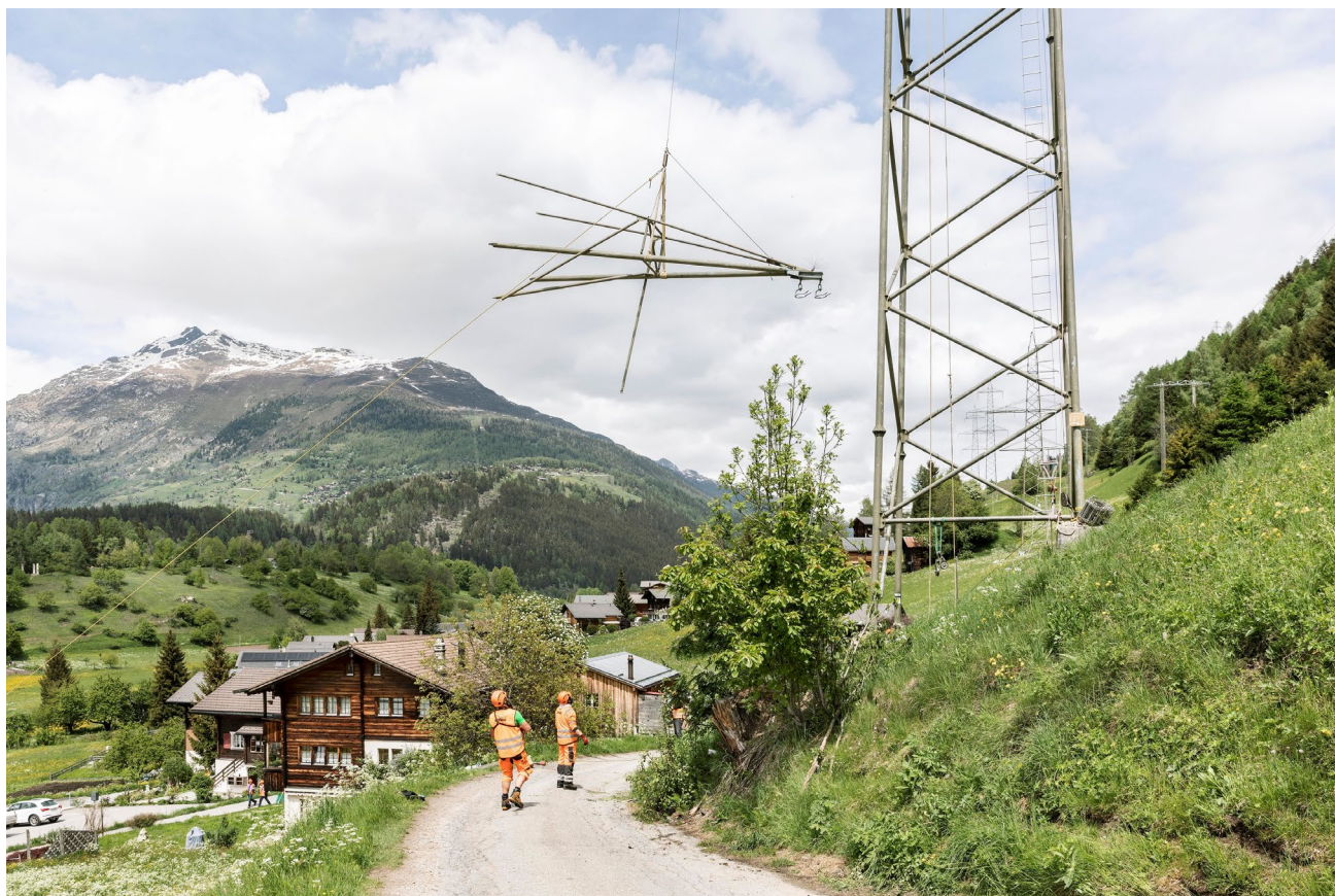
Rückbauarbeiten Ernen – Ulrichen, Mai 2020
