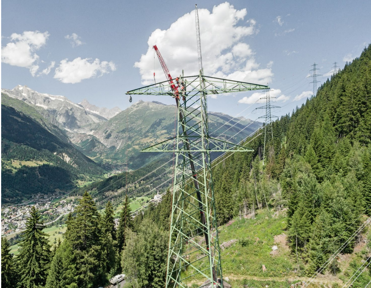
Montagenadel und Kran
